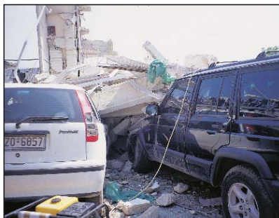
Αθήνα, σεισμός 1999. Η καταφυγή σε αυτοκίνητα ενδείκνυται μόνο αν παραμείνουν ακινητοποιημένα σε παρακείμενο χώρο στάθμευσης σε ασφαλή απόσταση από κτίρια, μαντρότοιχους κ.λπ.
