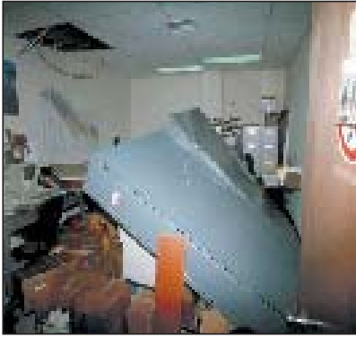
Χαρακτηριστικές πτώσεις μη ασφαλισμένων βιβλιοθηκών και ραφιών σε γραφειακούς χώρους μετά από σεισμικές δονήσεις.
