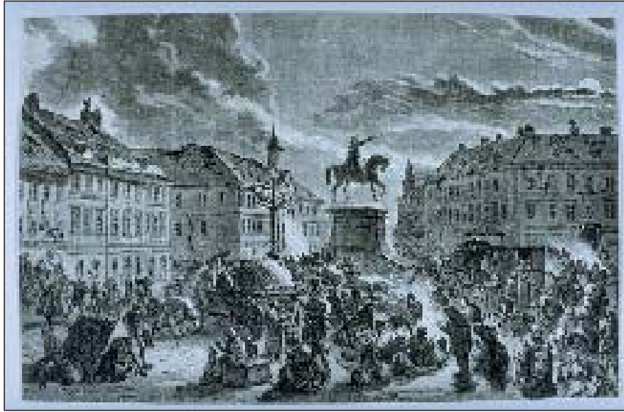
Ζάγκρεμπ, Κροατία, Σεισμός 9.11.1880: Ο κόσμος κατασκηνώνει στην πλατεία Jelacic (Πηγή: National Information Service for Earthquake Engineering, University of California, Berkeley, Kozak Collection) http://www.eerc.berkeley.edu/cgi-bin/kozak
